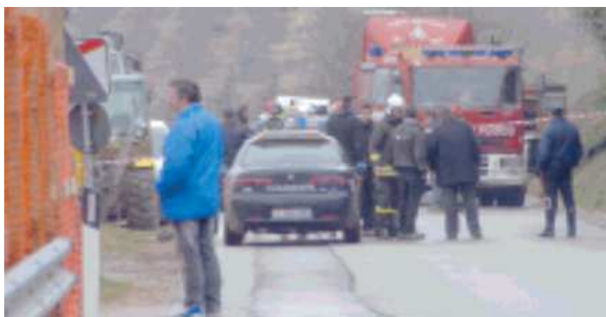
L'intervento di pompieri e tecnici al cantiere della nuova scuola: l'area è stata a lungo isolata (f. Fiorini)
